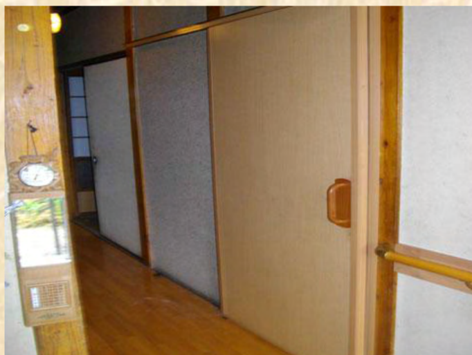
改修後(吊り引き戸)
