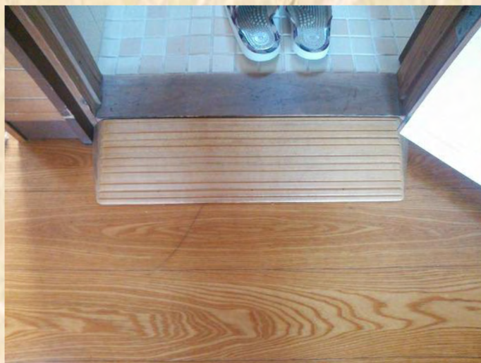
改修後(スロープ)
