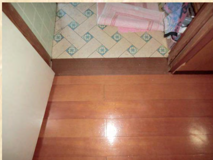
改修後(敷居撤去)
